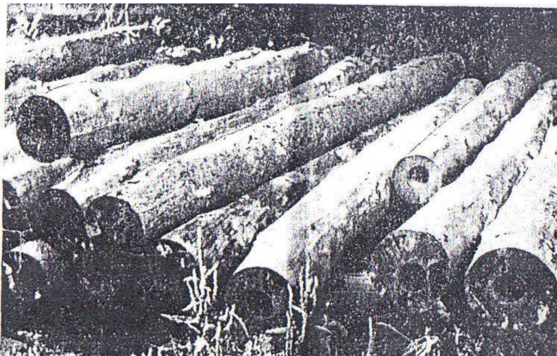
Obr. 3.20 Posledná fotografia drevených rúr, pripravených na výmenu z r. 1952 [11]
