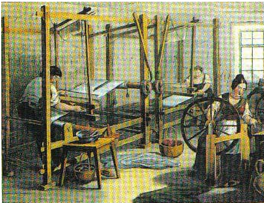
Obr. 6.23 Vzorovo zariadená tkáčska dielňa (litografia z r. 1835). Tradičné tkanie na krosnách. Prirážanie barda a prehadzovanie člnka je ručné a tvorba zivy sa ovláda nohami [21]
