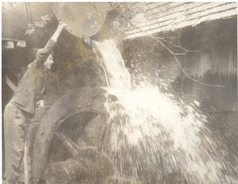
Obr. 1.67 ...a ešte keď bol v prevádzke
