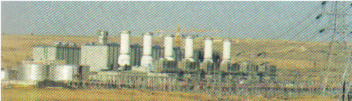
Obr. 1.238 Elektrárňu v Ambarli [21]
