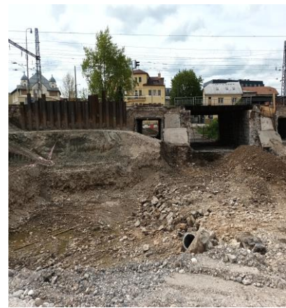
Objekt 50/32 10 realizovaný smerom do mesta , bol realizovaný ako mostovka kde sa nachádza železobetónový podchod.
