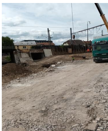
Oporný múr z larseniiek , je to paženie aby sa im nezosúvala pôda a aby mohli spraviť výkop.
