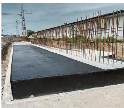
Základová doska, bude sa tu zalievať telo oporného múru.
