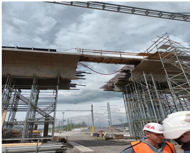
Konštrukcia je monolitická je to najdôležitejší objekt v tejto výstavbe. Pod každým pilierom sú pilóty, ktoré sú vystužené armokošmi.
